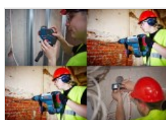
Prace instalatorskie w Łodzi
