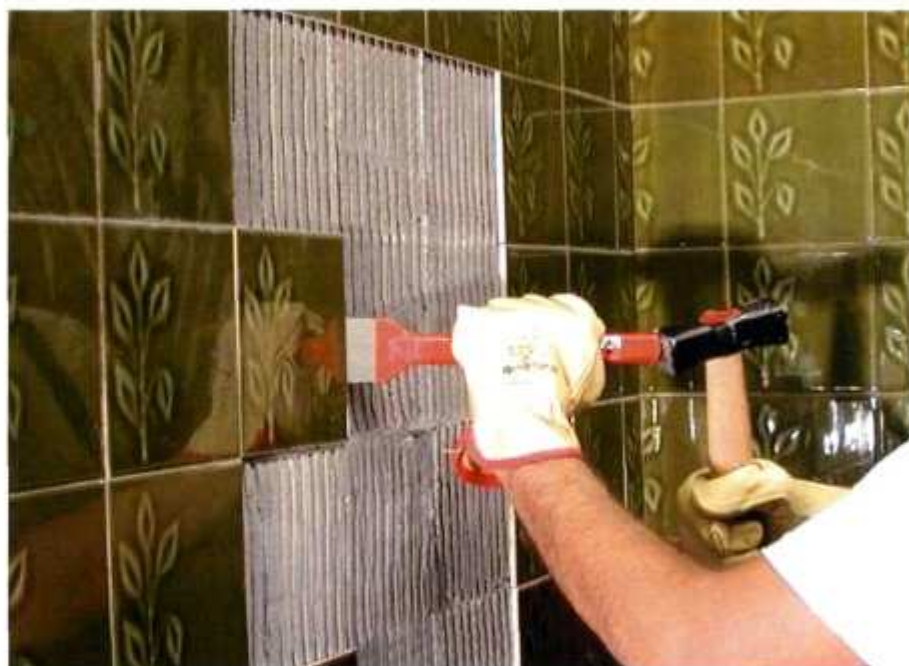
Przecinaki do demontażu charakteryzują się szeroką pletwą. Fot. Rubi – specjalistyczne narzędzia glazurnicze
